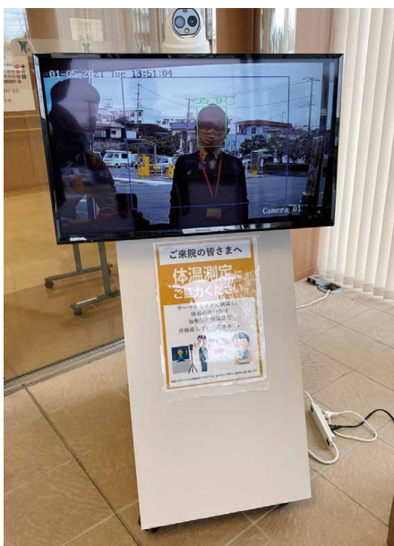
正面玄関にサーマルカメラを設置
